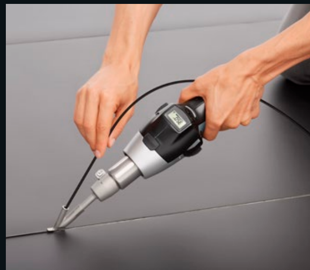
Svejsning af linoleumgulve.
