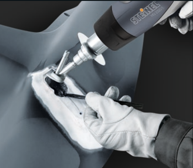
Reparation af revner i kofangere.
