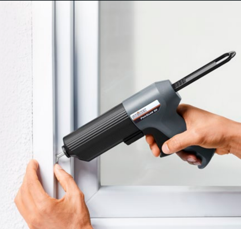
◀ Montering af plastprofil
